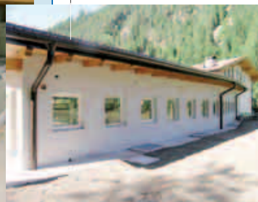
I lavori di realizzazione delle vasche alla piscina comunale di Predazzo e l'esterno della parte nuova della struttura (foto Mario Felicetti)
